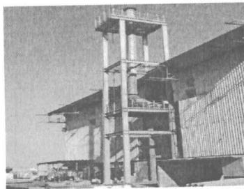
Foto 6. Nuevo sistema de evacuación de vapores de la zona de galvanizado en caliente.
